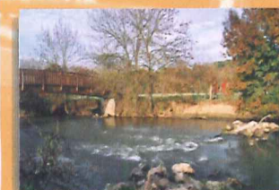
Passerelle sur la Cisse
